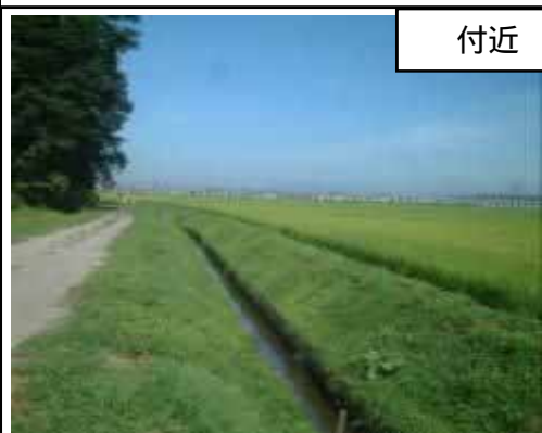
坂本様宅の後の開水路
