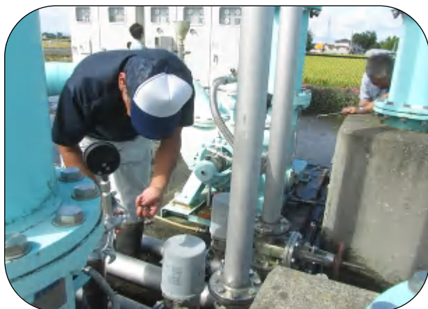
農繁期、田んぼの水掛に頑張ってくれたポンプに注油
