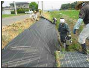
防草シート貼りでの一コマ
