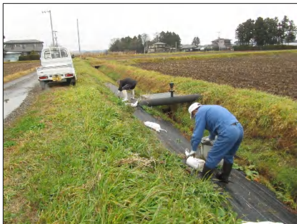
4月に張った防草シートが風などで飛ばないように重石代わりに土嚢袋を置いて
