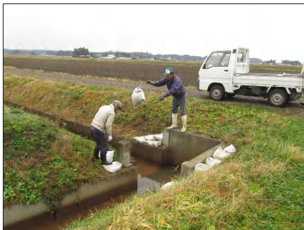
土嚢袋を放り投げて！
