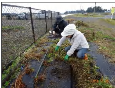
4月に張った防草シートが風などで飛ばないように重石代わりに土嚢袋を置いて
